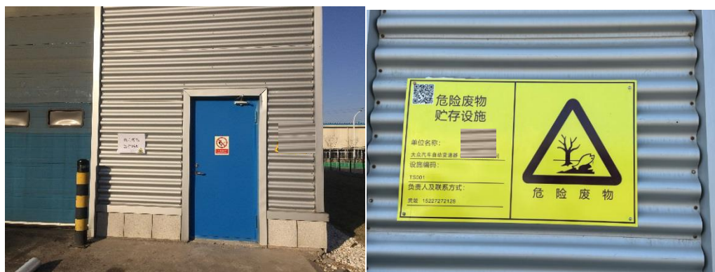
图 2-15 厂区现有危险废物暂存间照片
