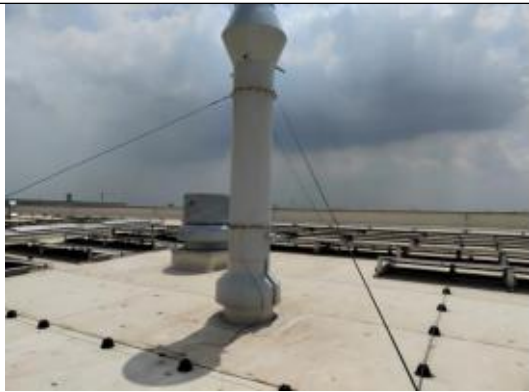
机加工含尘废气排气筒 P310-1
