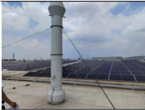
机加工含尘废气排气筒 P310-3
