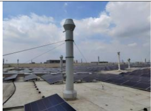
机加工含尘废气排气筒 P310-4
