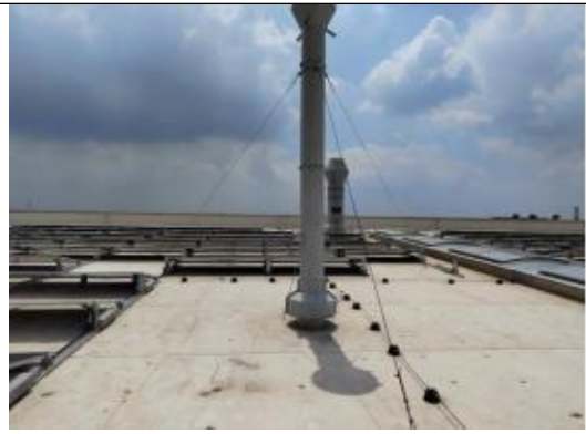
机加工含尘废气排气筒 P310-2
