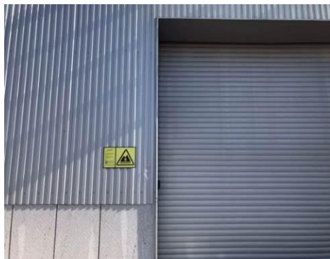
危险废物暂存库（仅存储污泥）
