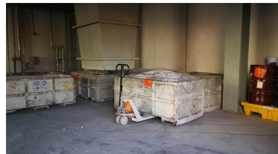
危险废物暂存库内部
