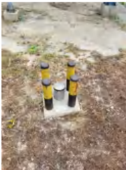
地下水监测井
