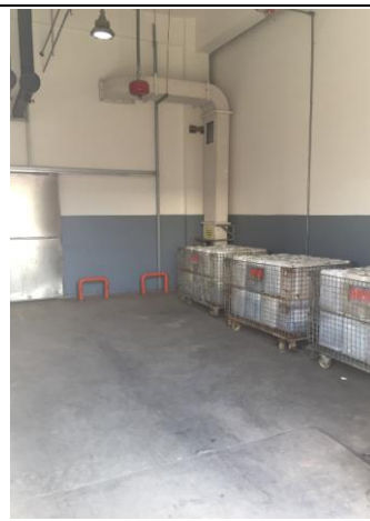
危废暂存间内部
