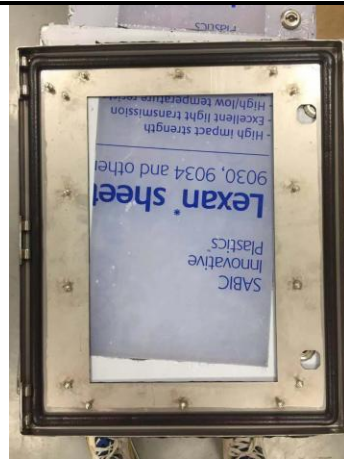
点胶完成后的配电柜外壳板 (来自同类企业)
