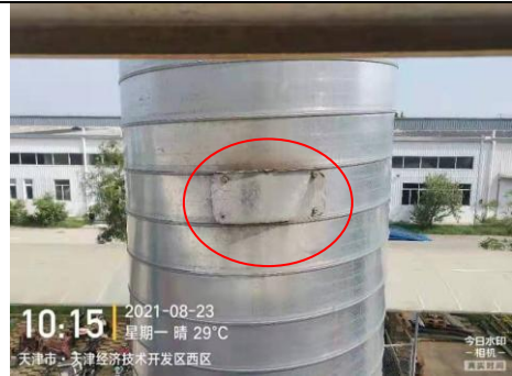
排气筒 P3 采样出口
