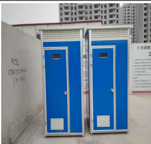
施工期移动厕所
