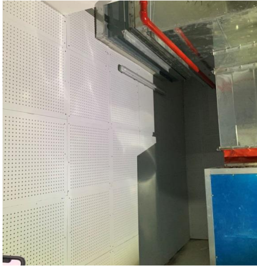
风机房墙面消声
