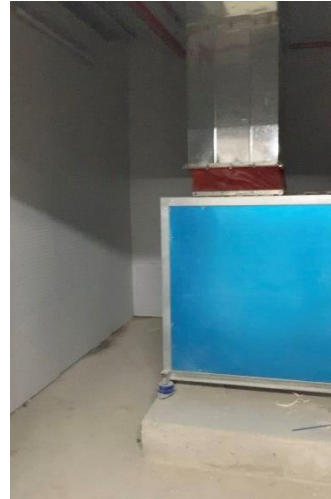
风机房基础减震
