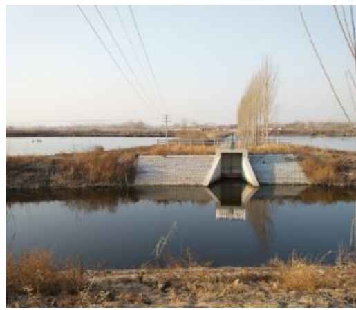
东粮窝支渠 1 节制闸
