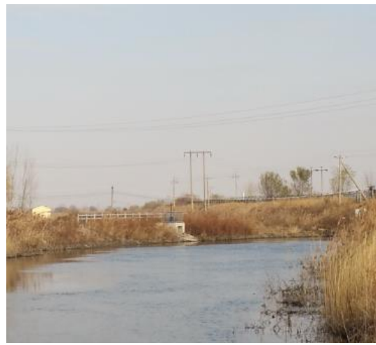
后苏庄北支渠节制闸
