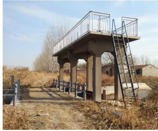
洪庄子泵站支渠 2 节制闸
