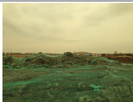
河道两侧堆土区
