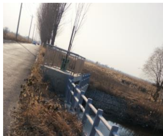
曹家港节制闸
