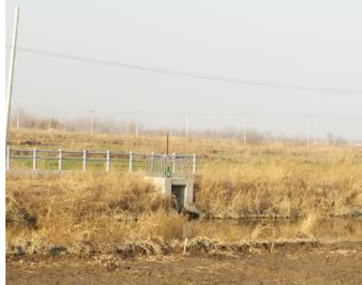
曹家岗桥西节制闸
