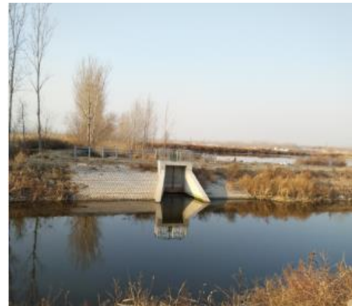
东粮窝支渠 3 节制闸
