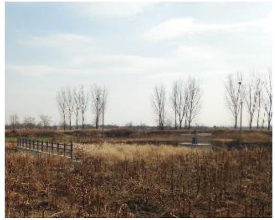
洪庄子泵站支渠 1 节制闸
