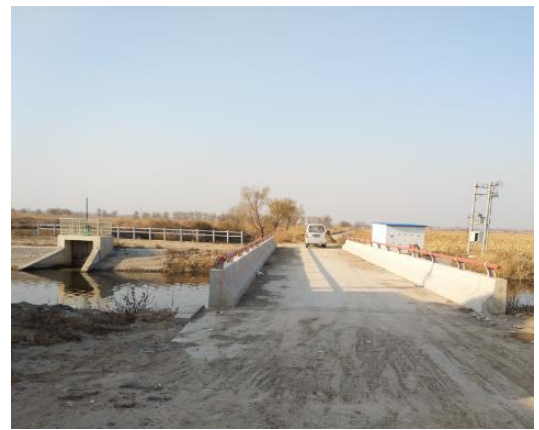
武安营桥及武安营支渠节制闸
