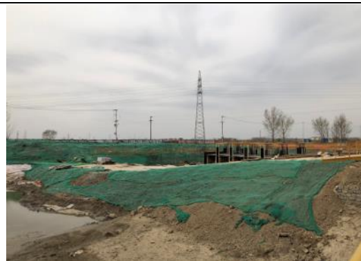
传递建筑物施工过程中苫盖措施
