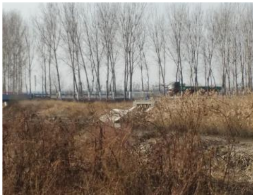
二支排渠节制闸
