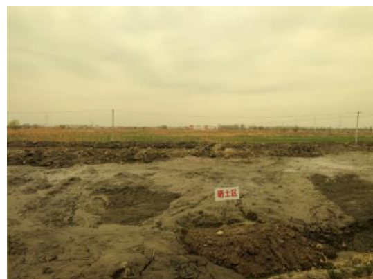
河道清淤后两侧为晒土区
