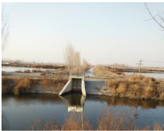
东粮窝支渠 2 节制闸
