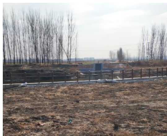
北引渠进口节制闸
