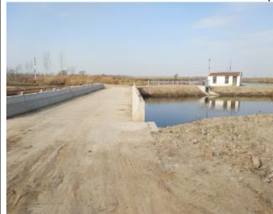
大宫城桥及大宫城桥东节制闸
