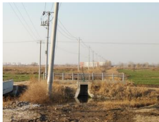
曹家岗桥东节制闸
