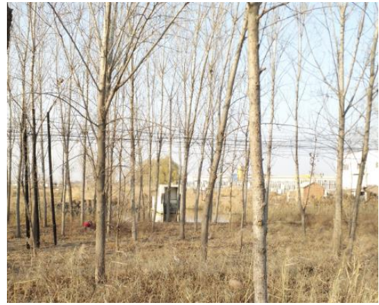
东高坑支渠 2 节制闸
