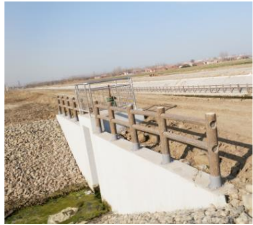
年辛庄桥南支渠节制闸
