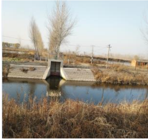
于家庄支渠 1#节制闸
