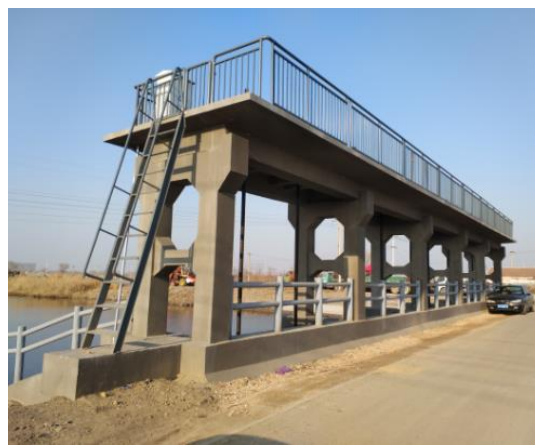
跨柳河节制闸
