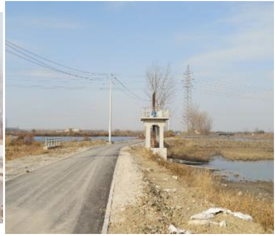
黄河河进水闸（右岸）
