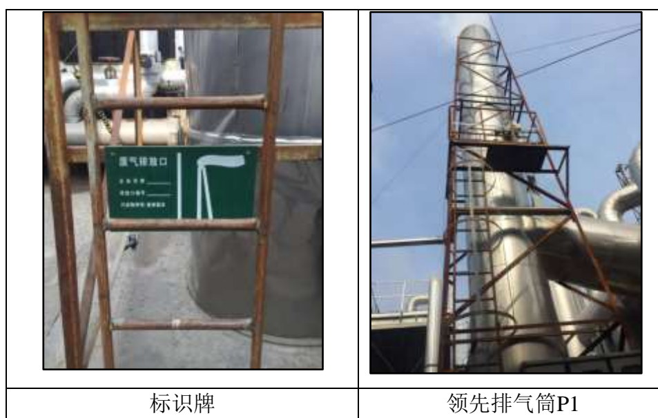
图 8 废物排气筒及标识牌
