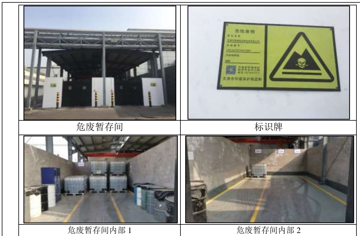
图 13 危废暂存间及标识牌
