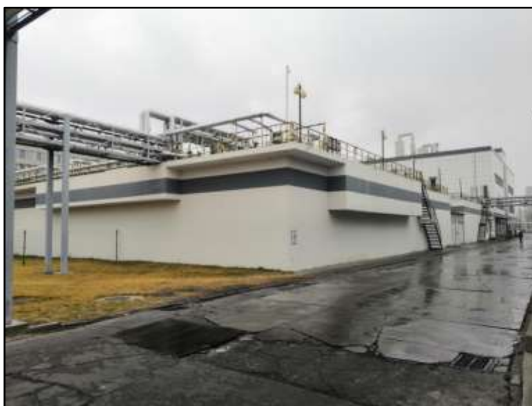
图 11 中环股份园区废水综合处理站
