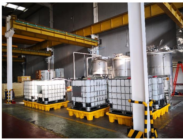
项目现场照片
