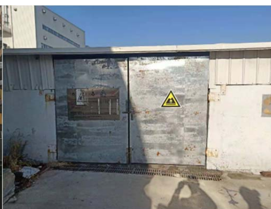
危险废物暂存间
