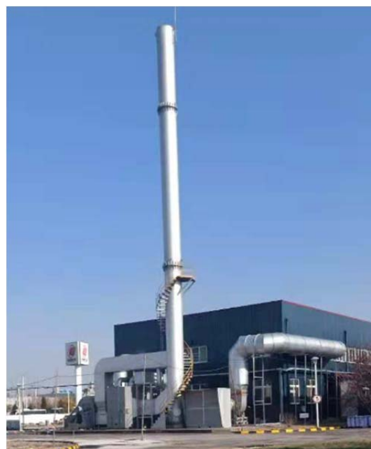
本次建设 30m 高排气筒
