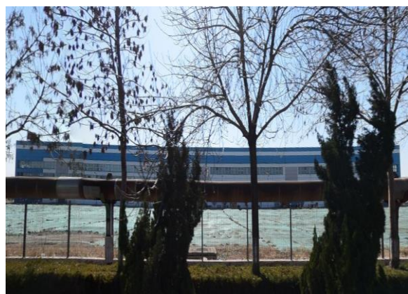
项目北侧奥的斯曳引机公司
