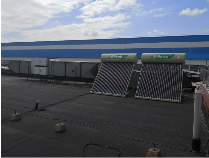
食堂油烟废气排放口
